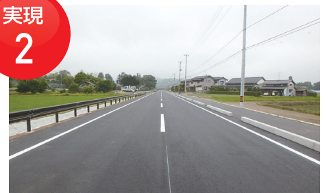
主要地方道岩沼蔵王線長岡地区道路改良工事。
