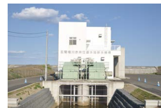
五間堀川遊水地排水機場
