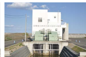
五間堀川遊水地排水機場
